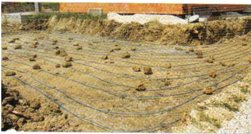
Slika 2a - klasični horizontalni kolektor
